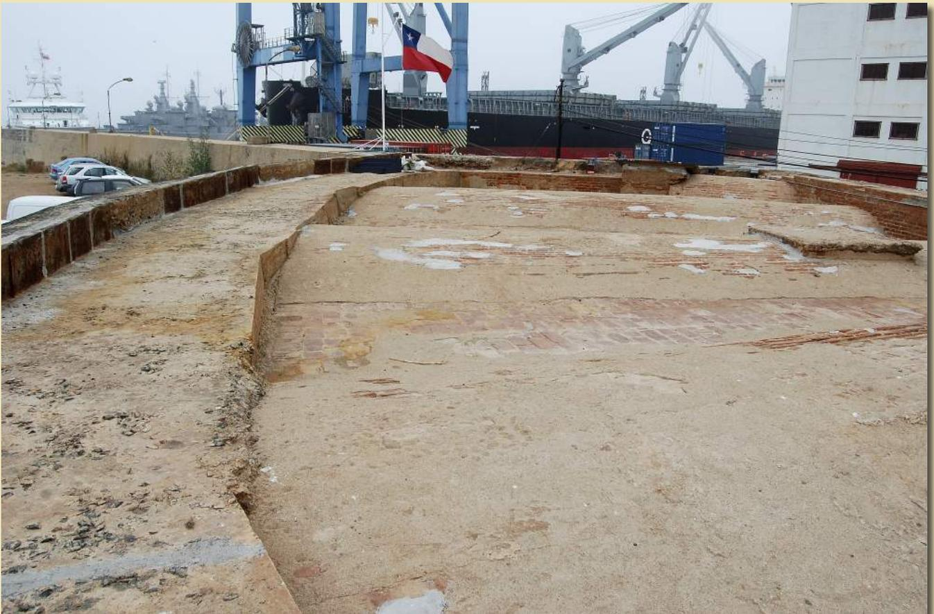
Cubierta de la batería; de izquierda a derecha: las planchas de blindaje de las corbetas "O'Higgins" y "Chacabuco" dispuestas verticalmente, el grueso muro del parapeto y luego, las bóvedas de ladrillo. Sobre este conjunto se depositó la capa de tierra apisonada, retirada por motivos estructurales (Fotografía del autor).
