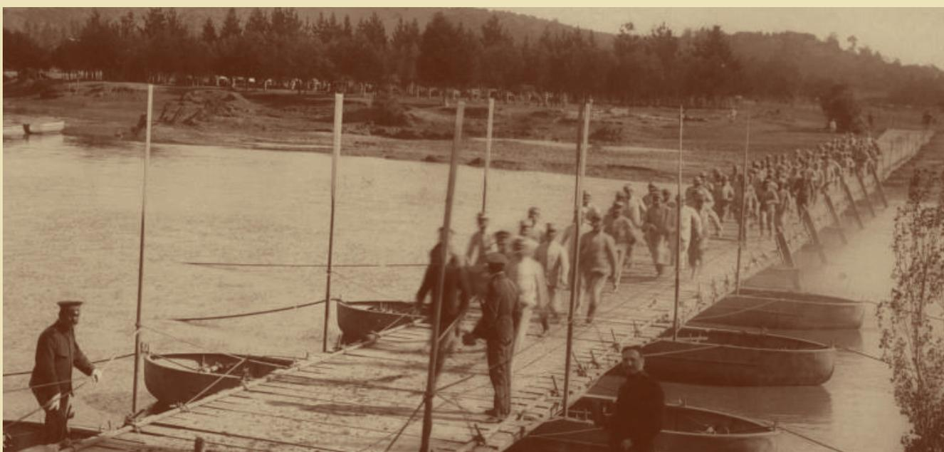
Sobre el puente, la tropa de la compañía que viste uniforme de brin lo cruza a paso ligero, para probar la estabilidad de la construcción. Al fondo, el parque de materiales, lugar donde se acopian los elementos para la construcción del puente, se aprecia el campamento y una embarcación sobre la orilla del río. <sup>DHM</sup>
