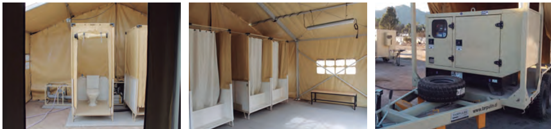
Carpa baños, duchas y grupo electrógeno para su funcionamiento.
