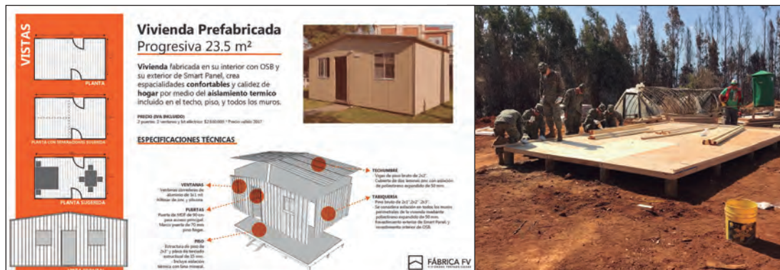
Apoyo del Ejército en armado de 33 viviendas de emergencia en comuna de Cholchol. Fuente: CGE Araucanía 2019.
