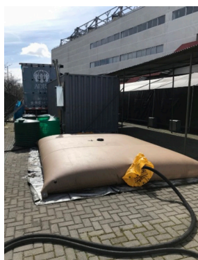
Estanque flexible de agua (5.000 litros), bombas de calor y carro climatizador. Fuente: Centro de Lecciones Aprendidas del Ejército.
