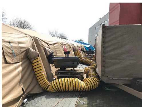
Estanque flexible de agua (5.000 litros), bombas de calor y carro climatizador. Fuente: Centro de Lecciones Aprendidas del Ejército.
